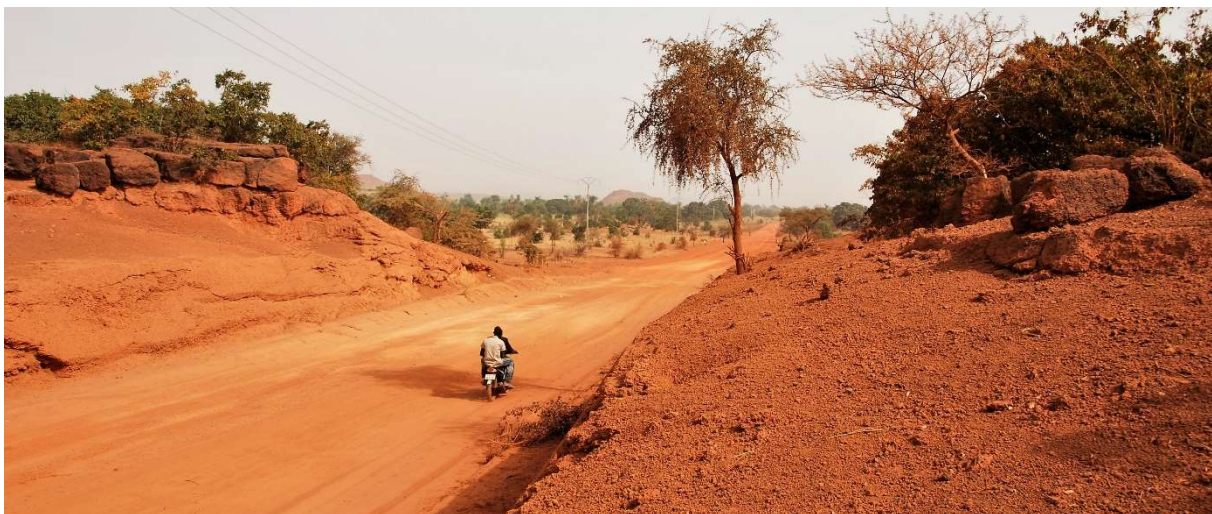
Route National N22 von Kongoussi nach Djibo
